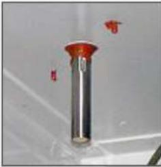
La rivelazione è affidata a due sensori di temperatura posti all'interno del vano macchina che monitorano continuamente eventuali aumenti di temperatura e in caso di anomalia mandano subito un segnale alla centrale. Il sistema è incrementato nella versione PRO con rilevatori UV/IR che migliorano i tempi di risposta.
