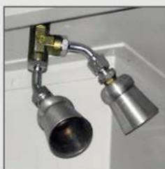
Il sistema di erogazione di Sentinel<sup>®</sup> risponde alle normative NFPA 12 riguardanti i gas ad alta pressione. All'interno del vano macchina vengono installati due o più coni erogatori in alluminio per garantire una corretta distribuzione della scarica del gas CO<sup>2</sup>.
